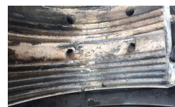
图 4 2018 年检修高压端轴封
